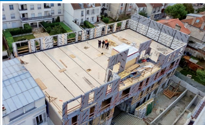
L'opération en cours de levage
