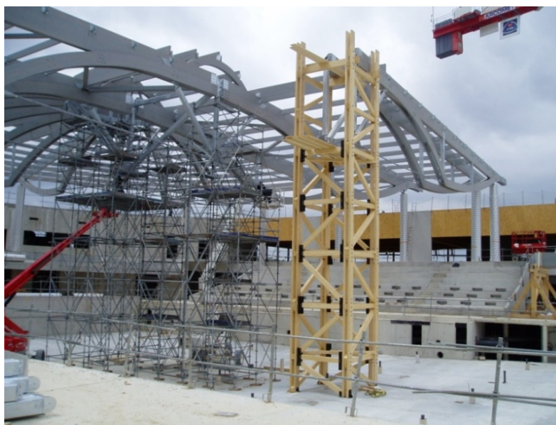
Photo 27 : Tours d'étalement et sapine
