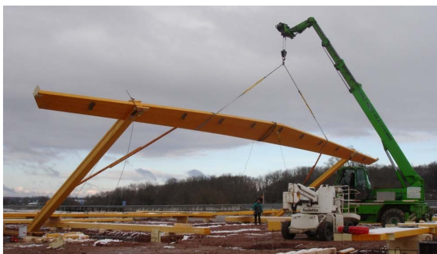
Photo 2: Levage de portique
