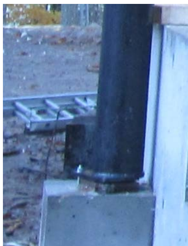
Photo 33: Calage provisoire de pied de poteau métallique
