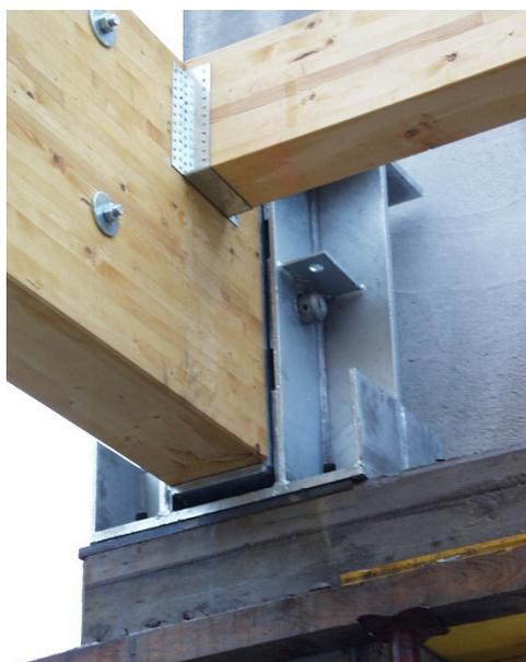
Figure 15.16 : Protection de l'appui à rotule d'extrémité
