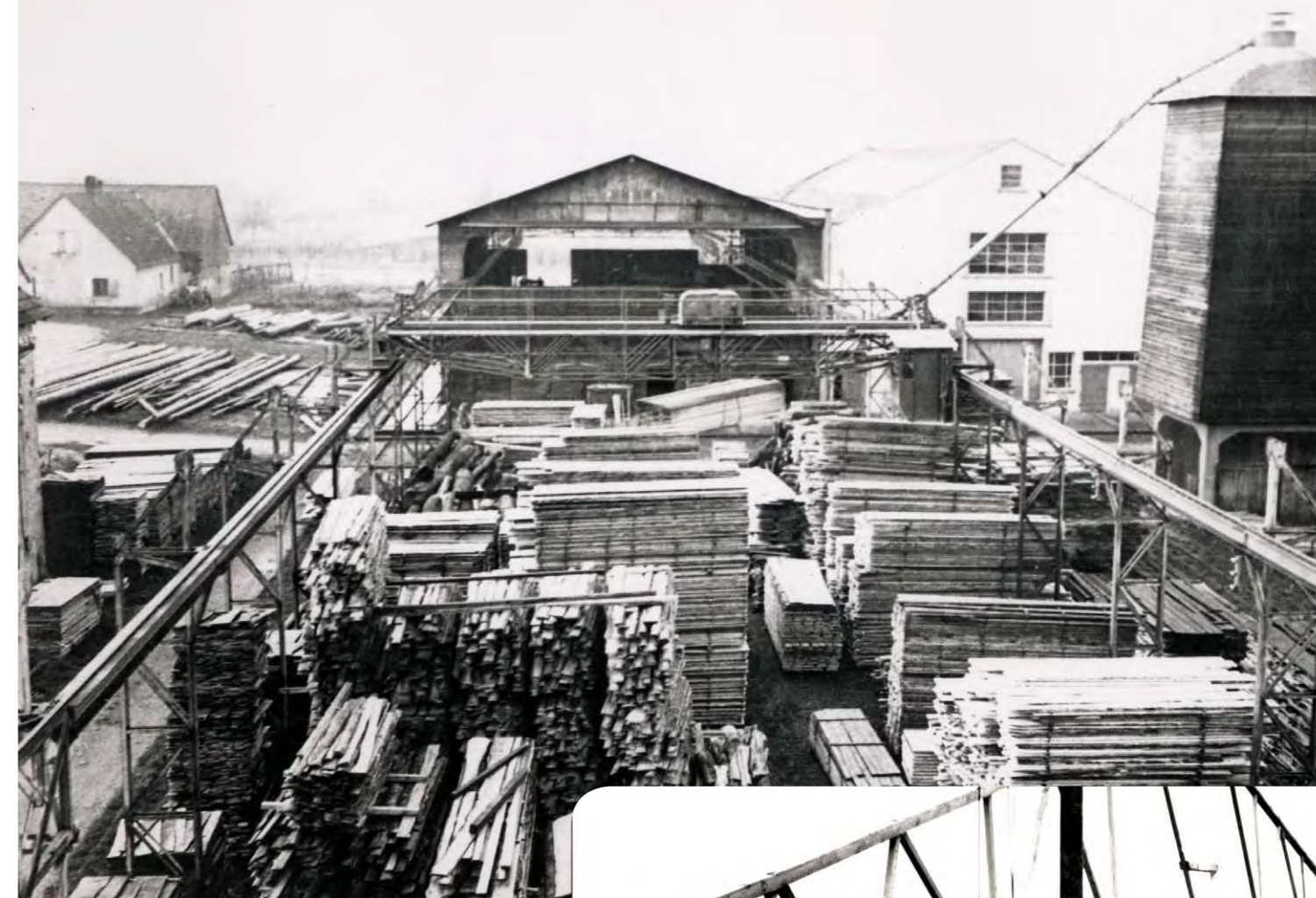
Atelier de charpente
